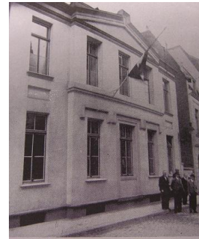
Gebäude an der Jackenstraße
